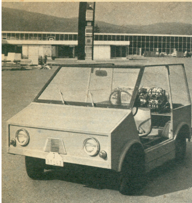
V prvním funkčním vzorku z r. 1969 se ověřovaly především vlastnosti pohonu.
